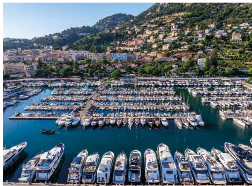
Courant 2026, des travaux de rénovation des Pannes 3, 8 et 9 seront lancés. During 2026, renovation work on pontoons 3, 8 and 9 will be launched.
